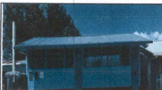
Foto 3: Pintura en muros exteriores (Modulo 1)
