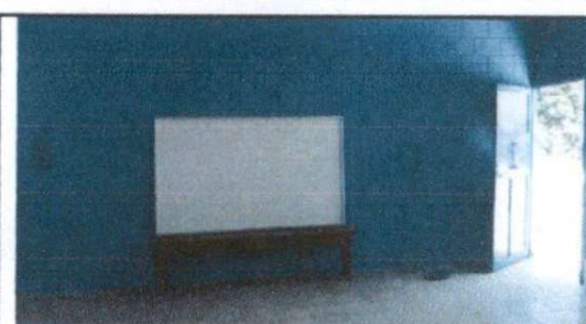
Foto 4: Pintura en muros interiores (Aula 1)
