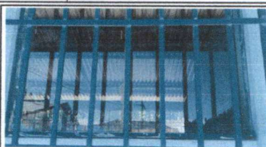
Foto 2: Sustrucción Estructura de Metal de Ventanas (Modulo 1)
